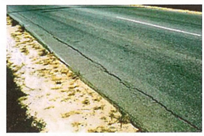
Edge Cracking
