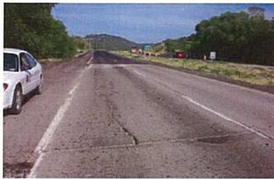
Longitudinal Cracking
