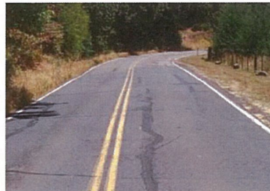
Longitudinal Cracking
